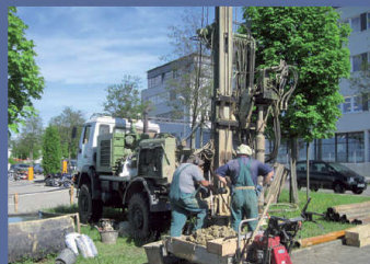
Geotechnische Erkundung bei der ARCUS-Klinik in Pforzheim
