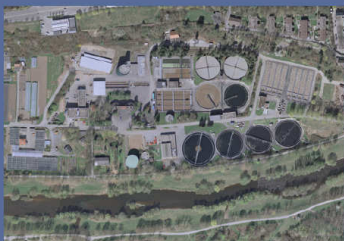
Kläranlage Pforzheim (250.000 E) Erweiterung um nachgeschaltete DN
