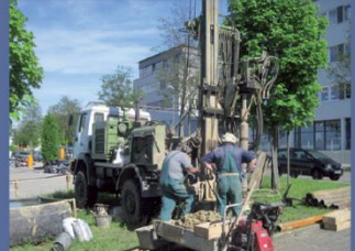
Geotechnische Erkundung bei der ARCUS-Klinik in Pforzheim
