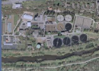
Kläranlage Pforzheim (250.000 E) Erweiterung um nachgeschaltete DN
