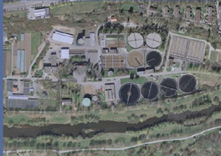
Kläranlage Pforzheim (250.000 E) Erweiterung um nachgeschaltete DN
