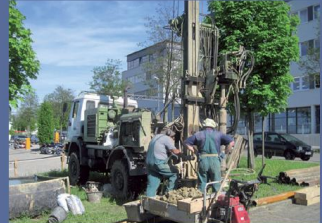
Geotechnische Erkundung bei der ARCUS-Klinik in Pforzheim
