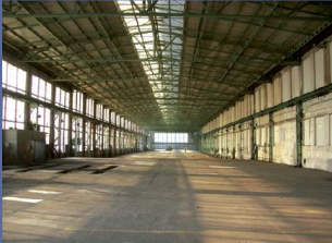
Ingenieurleistungen für den Rückbau des Luig-Areals in Illingen
